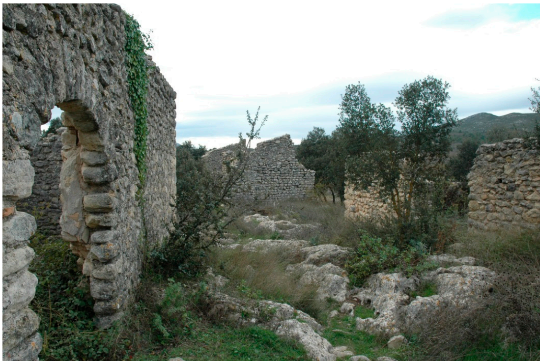
Figure 2. View of the current state of a case. Case: L’Atzuvieta, Vall d’Alcalà.
